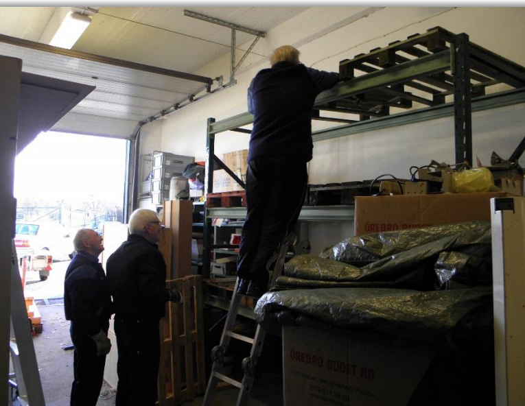
Ett pallställ byggs upp på den platsen som megamaten tidigare var placerad på. Göran o Pelle o Jan-Åke med flera hjälper till.
